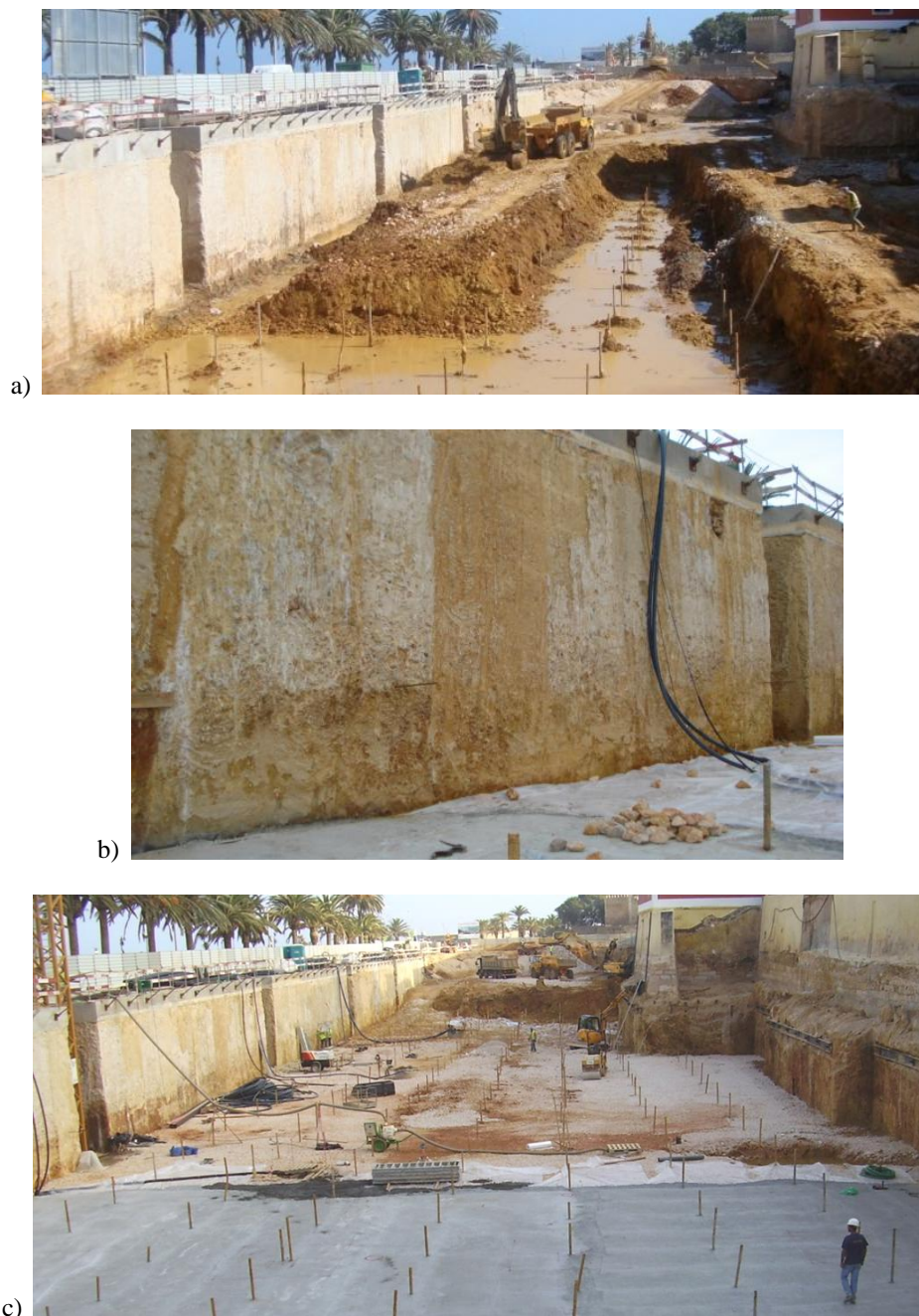
Figura 6 – Aspecto Geral da Obra nas várias Fases de Execução: a) Escavação até à Profundidade de 6 m; b) Pormenor da Parede de CSM; c) Regularização do Fundo de Escavação e Aplicação do Betão de Limpeza
