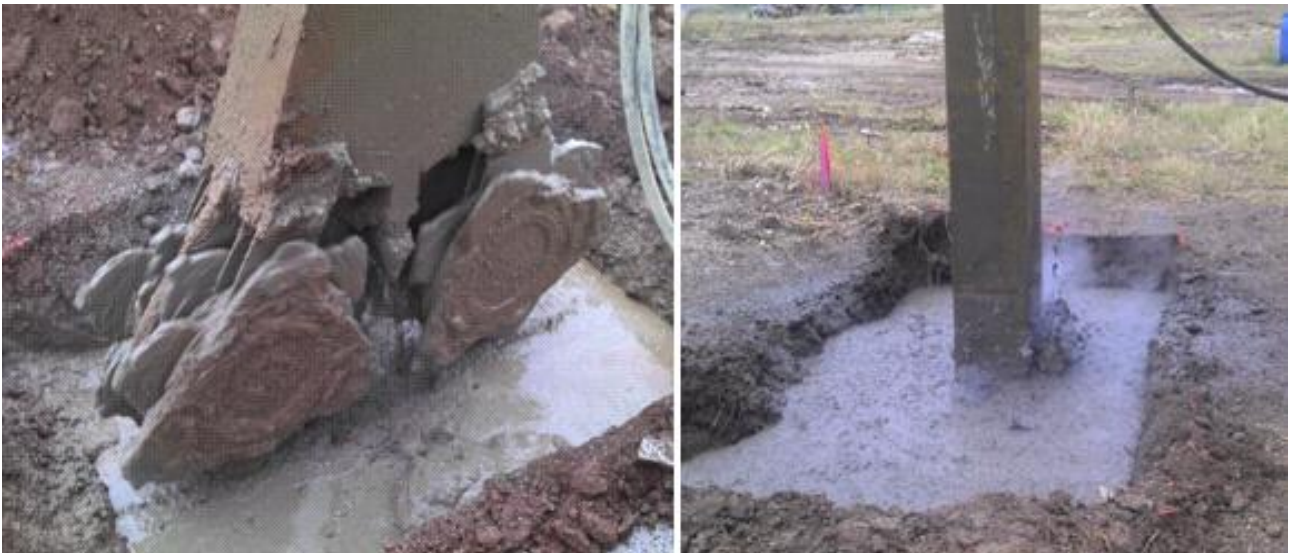
Figura 9 – Vistas do equipamento durante a execução de um painel de CSM
