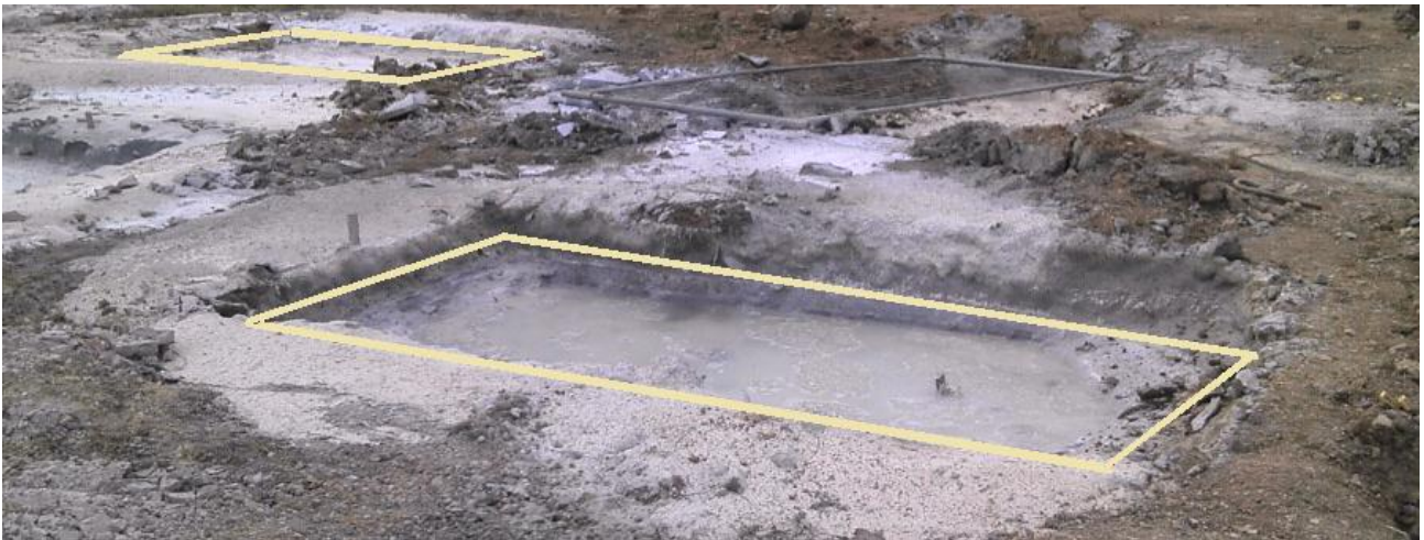
Figura 7 - Vista dos capitéis de alguns dos painéis de CSM executados
