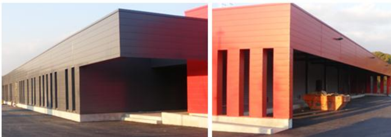
Figura 13 – Vistas do exterior do edifício industrial executado
