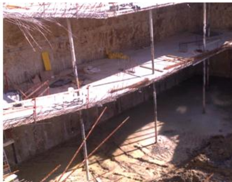
Figura 14 – Fotografia da obra após a escavação até à profundidade máxima
