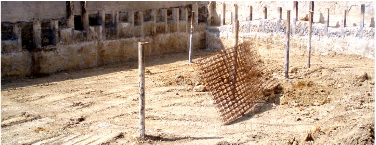
Figura 9 – Microestacas de fundação executadas para apoio provisório das bandas de laje
