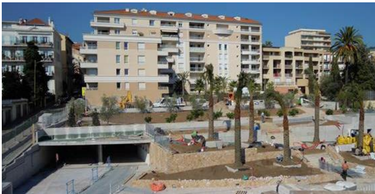
Figura 15 – Aspecto geral na fase final da obra
