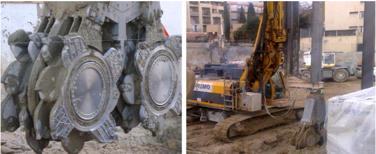
Figura 3 – Pormenor da ferramenta de corte (à esquerda) e aspecto geral do equipamento de execução dos painéis CSM (à direita)
