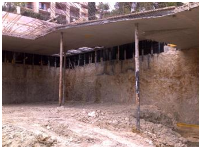
Figura 13 – Fotografia da obra após a escavação para a execução do 2º nível de travamento
